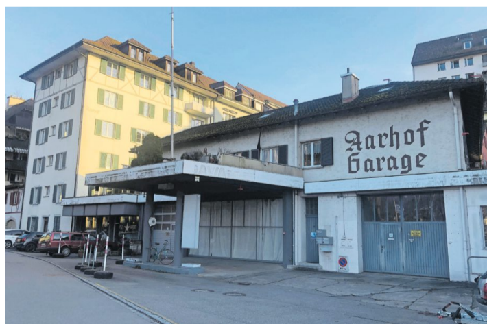
1950 wurde die Aarhof Garage an der Mühlemattstrasse gebaut, nun wird sie saniert. Bild: Katja Schlegel
