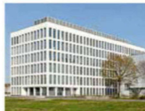
Verwaltungsgebäude Roche B12R, Rotkreuz
